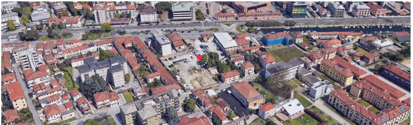
Vista aerea dell'ambito d'intervento, tra via Pepe e via Fedeli nei pressi del centro di Mestre.
